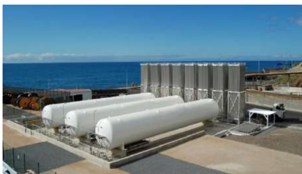
Figure 3.10 – LNG bunkering station
